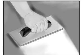
3- Inmediatamente coloque el geotextil y extiéndalo sin dejar traslajos ni pliegues sobre la superficie y con la misma plancha lisa presione hacia abajo.
